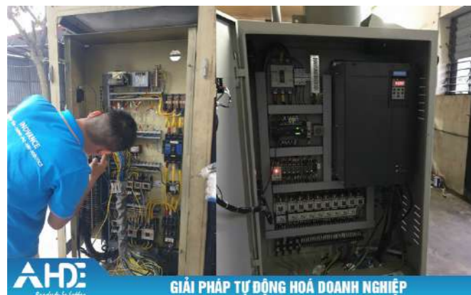
GIẢI PHÁP ĐIỀU KHIỂN MÁY NÉN KHÍ DÙNG BIẾN TẦN TẠİ HƯNG YÊN
