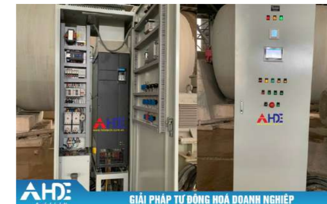
GIẢI PHÁP ĐIỀU KHIỂN MÁY NGHIỀN BI DÙNG BIẾN TẦN TẠİ HÀ NAM
